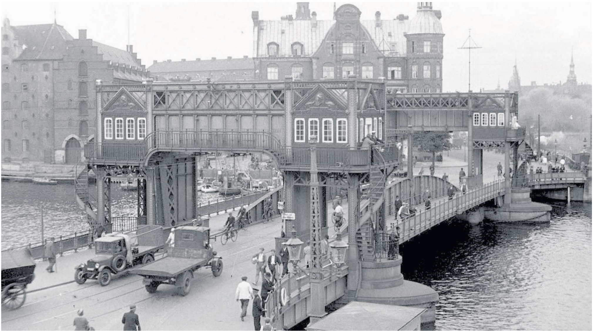
August 1933: Broen fra 1908 set fra Christianshavn mod nordvest. Foto: Erik Johansen. Billedet tilhører Sundby Lokalhistoriske Forening og Arkiv.
