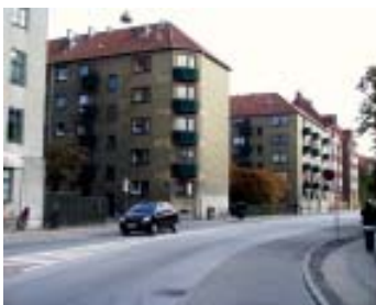
Sundholmsvej set mod øst. I forgrunden ses bebyggelsen i gule mursten, der er beliggende på hjørnet ved Norgesgade. I baggrunden skimtes bebyggelsen i røde mursten fra 1914.
