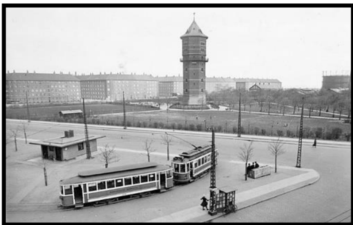
Endestationen for Linje 5 ved Sløjfen på Øresundsvej og med Sundby vandtårn (nedrevet 1967) i Lergravsparken.
