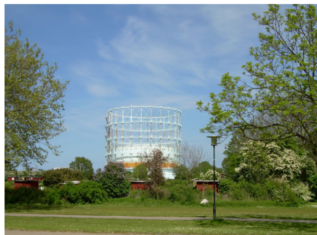
Gasbeholderen ved Sundby Gasværk med kolonihavekvarteret i forgrunden
