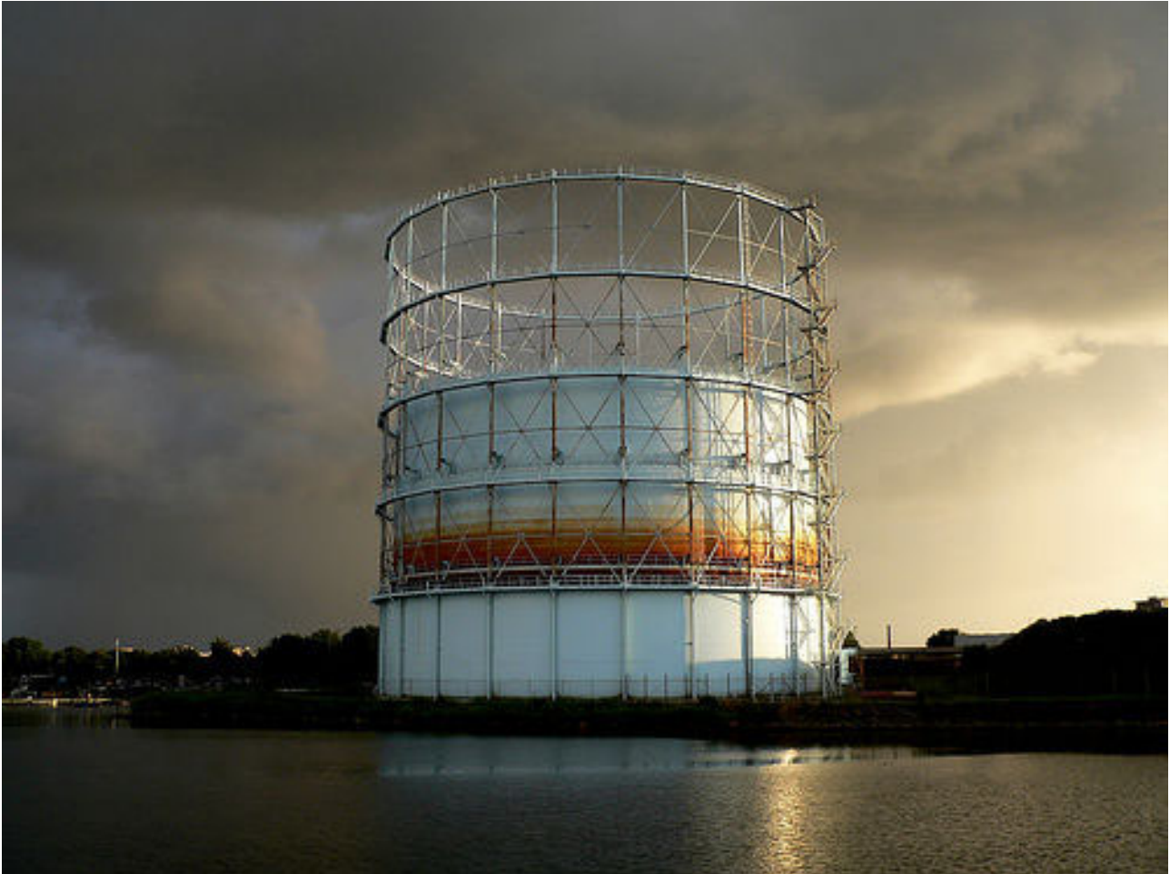
Den store gasbeholder på Sundby Gasværk. Foto: Stig Nygaard.
