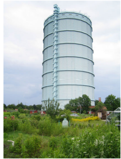
Valby gasbeholder fra nyttehaver ved Valbyparken
