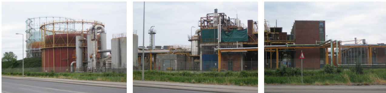
Sundby Gasværk fra Prøvestensvej – på billedet til højre ses i baggrunden den store vådgasbeholder fra 1971 og i forgrunden den lille vådgasbeholder fra 1964.
